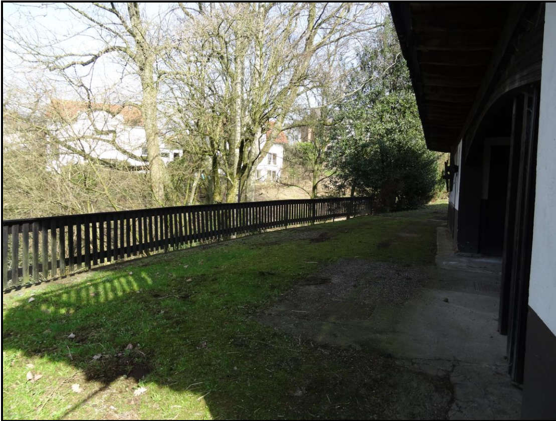
Vorhandenes Wohnhaus mit angrenzenden, bewaldeten Talhängen (Blick nach Nord-westen)
