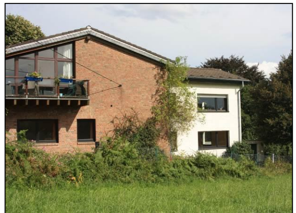
Mehrfamilienhaus am südlichen Rand der Ortslage
