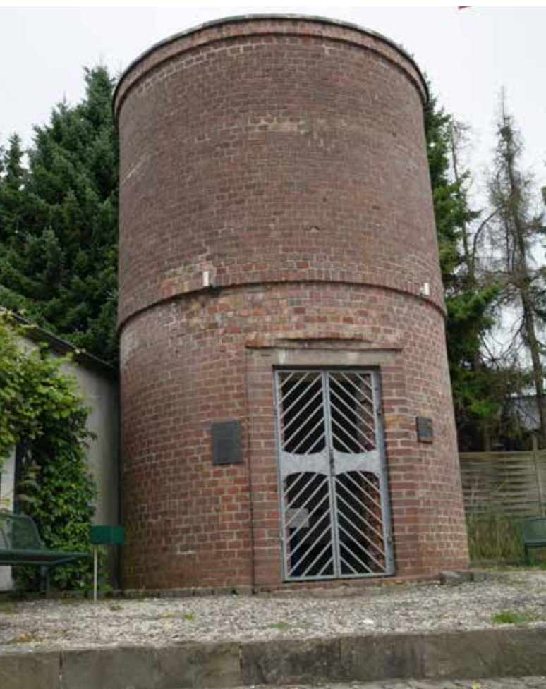
Historischer Wasserturm in Neschen
