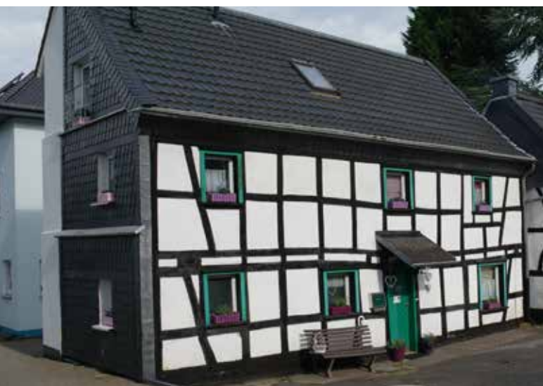
Ansprechende und gepflegte historische Bausubstanz
