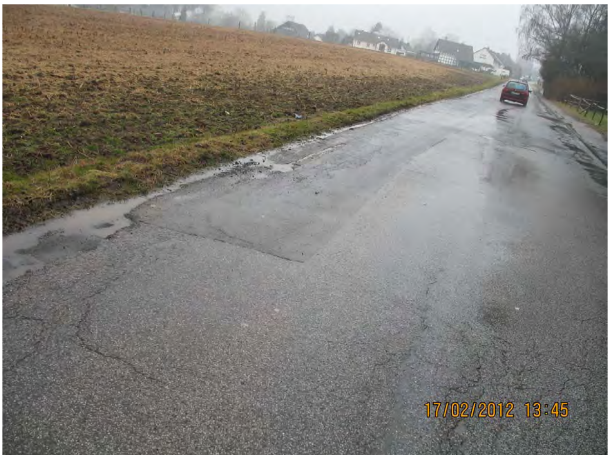
Küchenberger Straße zwischen Odenthaler Str. und Oberbech
