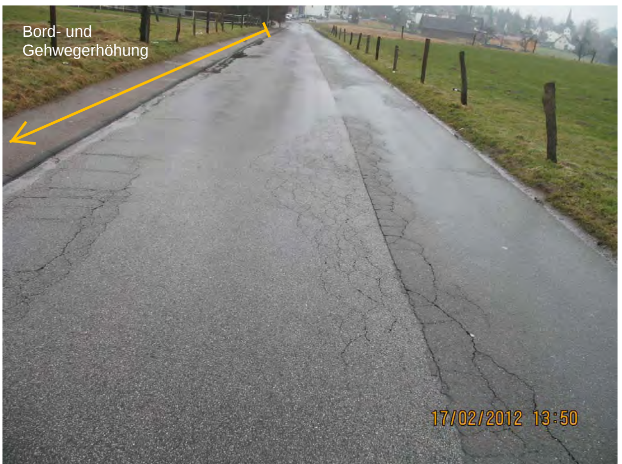
Küchenberger Straße zwischen Odenthaler Str. und Oberbech
