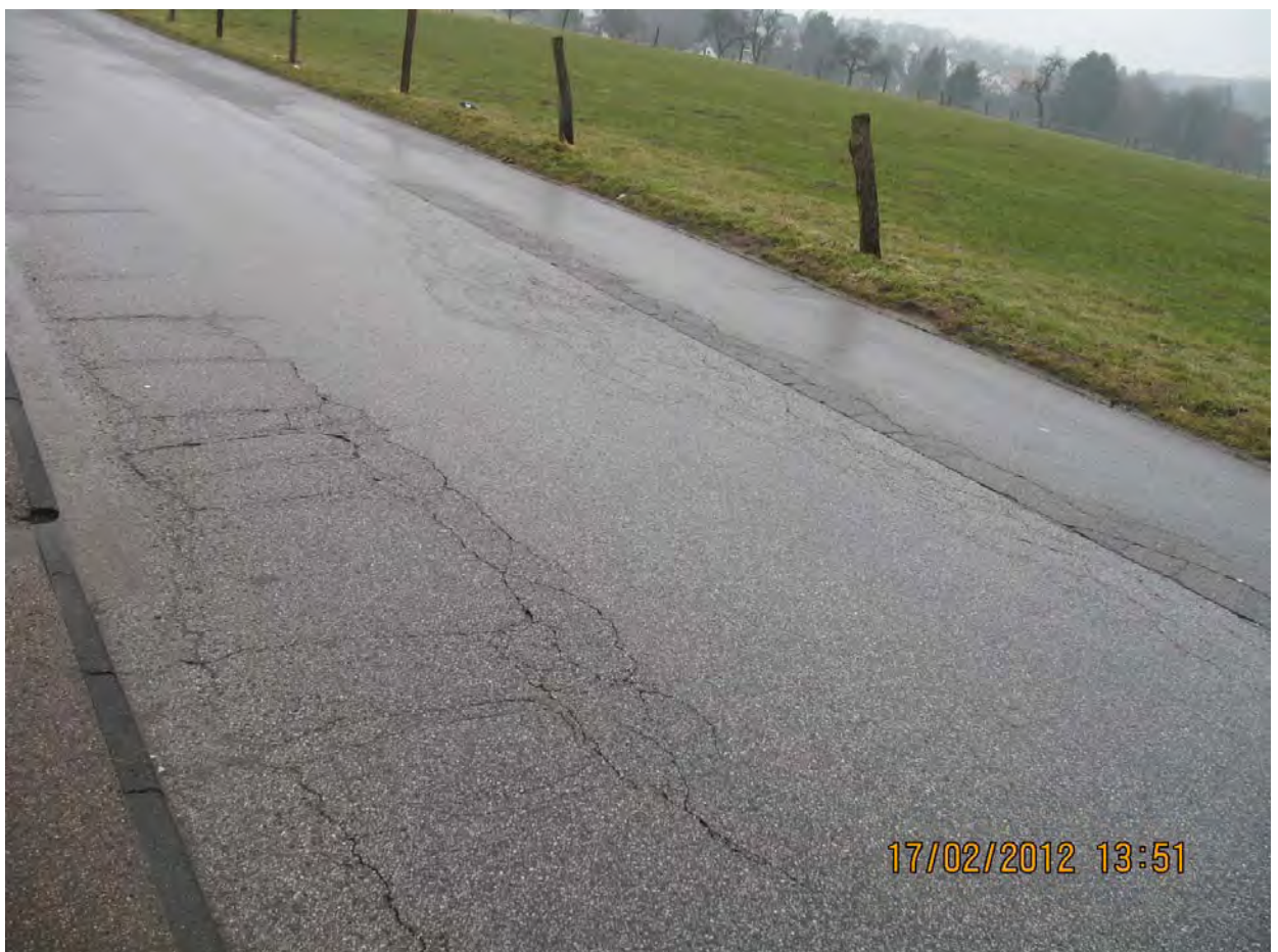
Küchenberger Straße zwischen Odenthaler Str. und Oberbech
