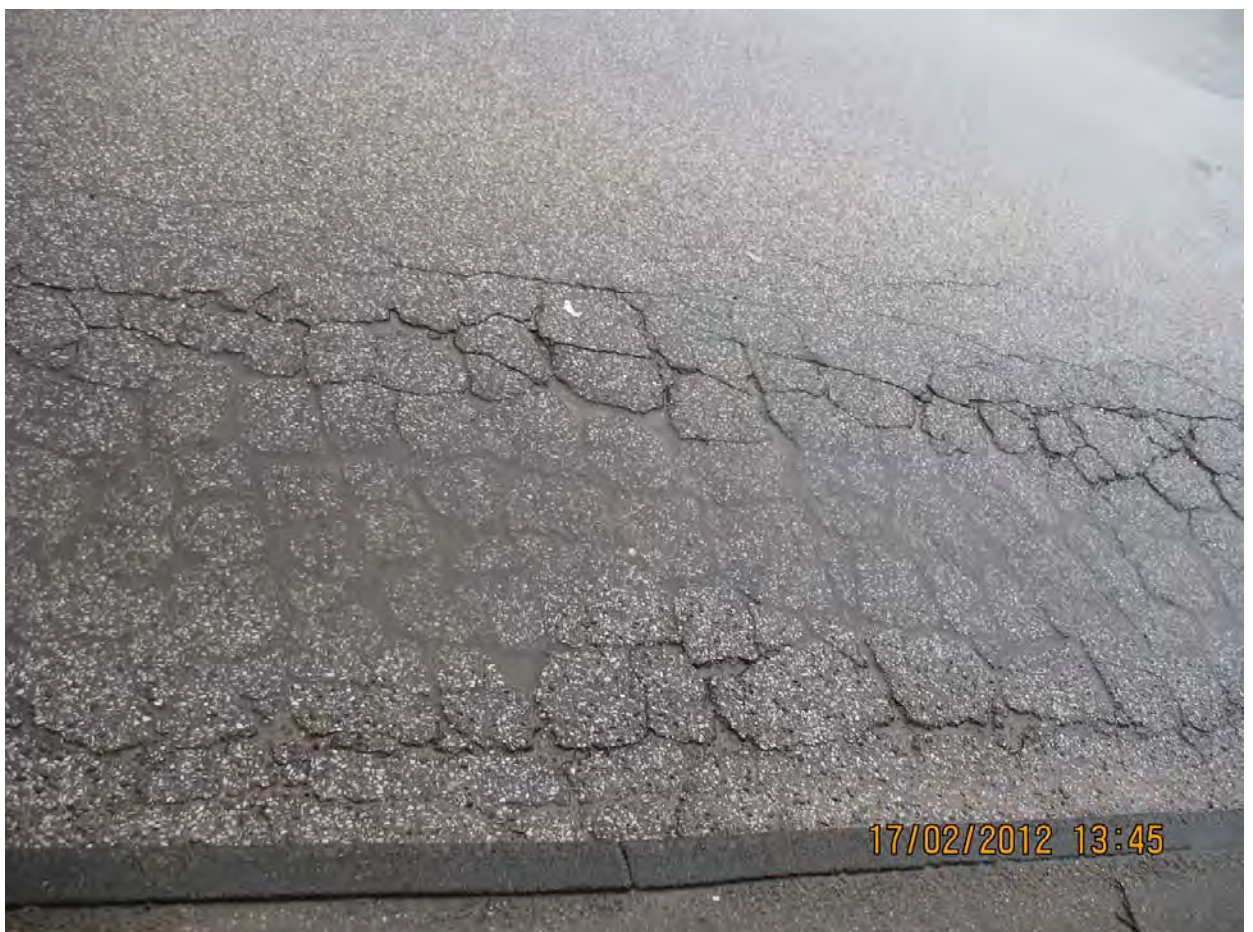
Küchenberger Straße zwischen Odenthaler Str. und Oberbech
