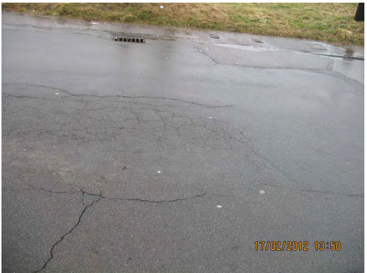
Küchenberger Straße zwischen Odenthaler Str. und Oberbech
