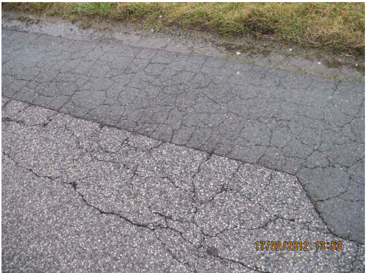
Küchenberger Straße zwischen Odenthaler Str. und Oberbech
