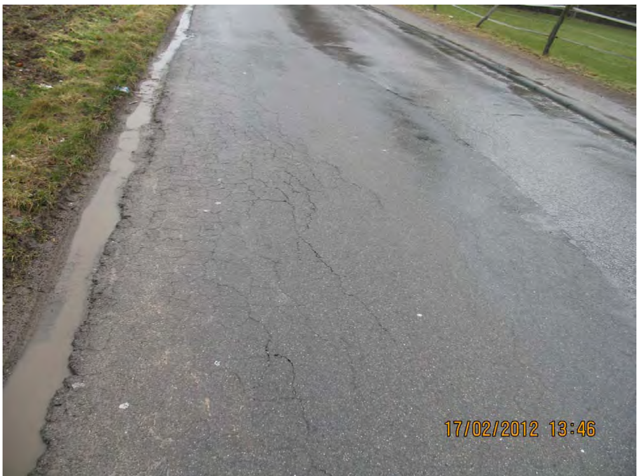
Küchenberger Straße zwischen Odenthaler Str. und Oberbech
