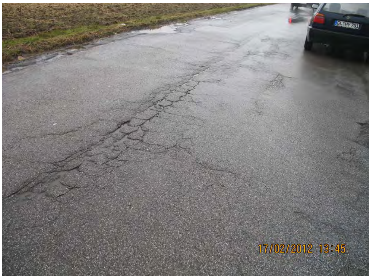
Küchenberger Straße zwischen Odenthaler Str. und Oberbech
