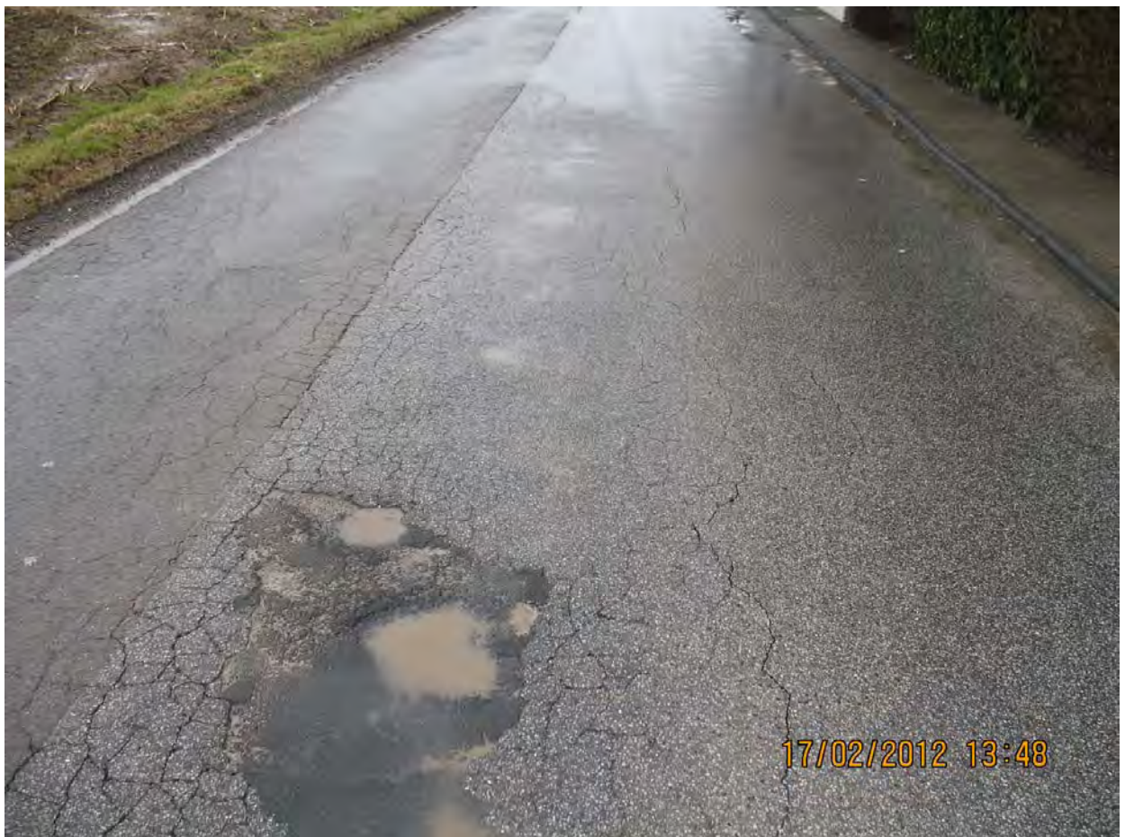
Küchenberger Straße zwischen Odenthaler Str. und Oberbech
