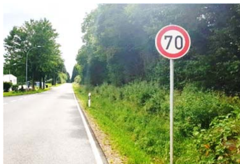
Lesbarer Straßenraum auf einer Kreisstraße im Kreis Euskirchen (Quelle: VIA eG)
