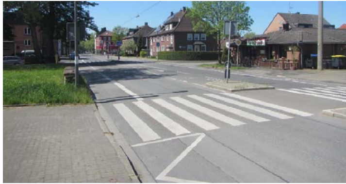
Fußgängerüberweg mit Mittelinsel, Musterbeispiel Corsfeld (Foto: VIA eG)
