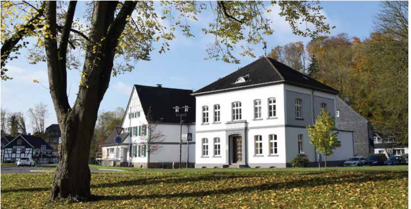
Nach umfangreicher Fassadensanierung erstrahlt das Odenthaler Rathaus in neuem Glanz. Foto: Martin Stein
